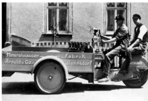
Dreirad „Selterwasser-Arnold“ Gaststätte „Sängerhalle“
