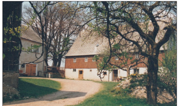
Bild 3 – Gut Oberer Gutsweg 7: altes Wohnhaus (Aufnahme 2002)
