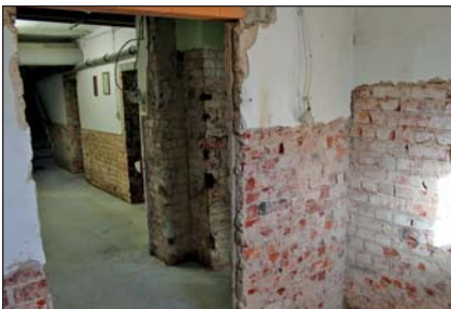
Ident-Nr. 2406 Instandsetzung Kellergeschoss Rathaus -Hochwasserschutzmaßnahme 2013-
