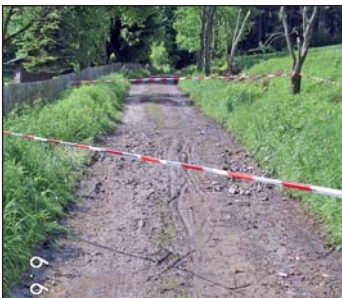
Ident-Nr. 1827 Wegebefestigung am Naturbad Die Realisierung dieser Hochwasserschutzmaßnahme ist ebenfalls in Arbeit. Dazu wird der Gemeinderat in seiner Sitzung am 20.09.2016 einen Beschluss zur Vergabe der Bauleistung fassen. Baubeginn dieser Straßenbaumaßnahme ist ab 17.10.2016. (Foto aus dem Jahr 2013)
