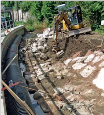
Ident-Nr. 20095 Instandsetzung Dorfbach in der gesamten Ortslage -Hochwasserschaden 2013-
