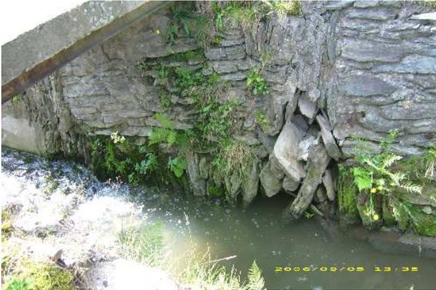
Die Firma M&S Bau und Betonstein GmbH aus Thalheim wird im September 2006 mit der Bachbettsanierung einschließlich Unterfangung der angrenzenden Ufermauern im Bereich der Fußgängerbrücke am Sportplatz Volkshaus begonnen. Auf einer Länge von ca. 10 m wird das stark ausgespülte Bachbett befestigt und die angrenzenden Ufermauern gesichert.
